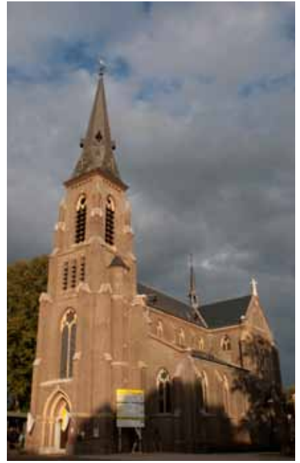
Voltooiing restauratie, St.-Antonius-van-Paduakerk, Kranenburg. Foto's: Henk-Jan Panneman
